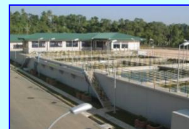
キャンディー市浄水場 (処理水量: 36,600m 3 /日)
